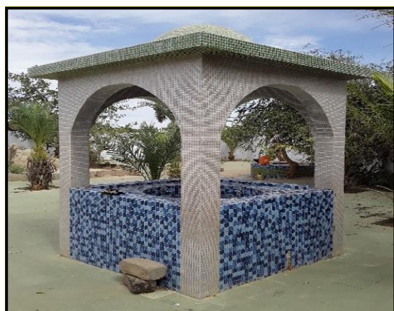
Fontaine de robinets reliée au puits de Sokhna Asta Waalo Mbacké, à Nawel.
