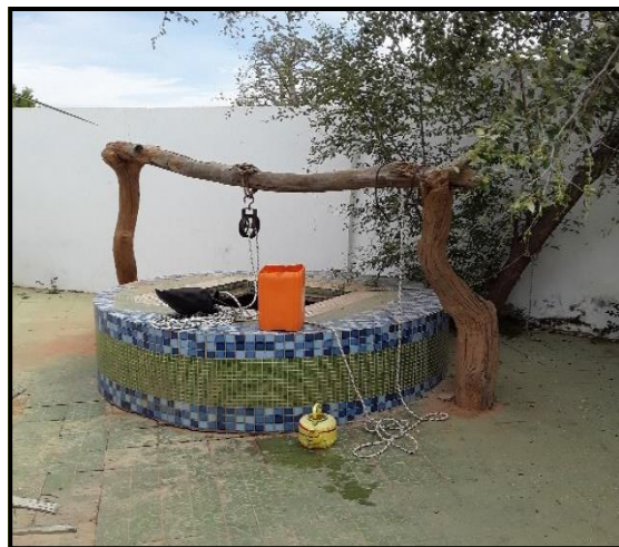
Aspect actuel du puits de Naawel après qu'il soit de nouveau creusé et surmonté d'une margelle fermée.
