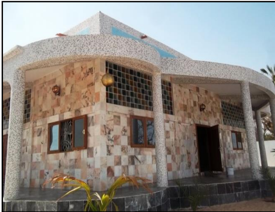
Mausolée de Sokhna Asta Waalo Mbacké à Nâwel, rénové avec le Ndigeul de feu Serigne Ibra Bouso, arrière-petit-fils de la sainte Sokhna
